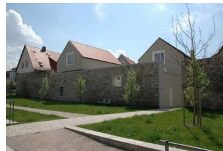
Nordöstlicher Abschnitt, Höhe Kanalstraße
